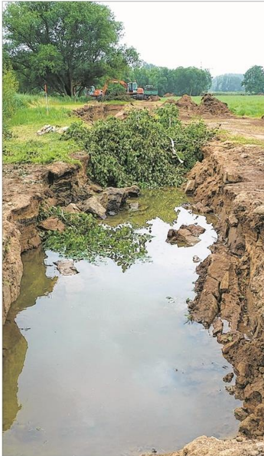
Frisch ausgebaggert ist dieser Teil des zukünftigen Biotops. Die Auenlandschaft wird in mehreren Abschnitten wiederhergestellt. Fotos: Ursula Holtgrewe
