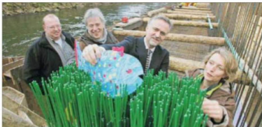
Sie informierten sich über den reibungslosen Ablauf der Bauarbeiten (von links): Lutz Vorreyer, Detlef Gerdts, Stadtrat Wolfgang Griesert sowie Christiane Balks. Foto: Jörn Martens
