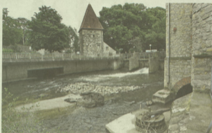
Die Wasserkraft wurde an der Pernickealmühle schon seit eh und je genutzt. Die Reste der bislang letzten Turbine sind noch auf dem Betonfundament am Auslauf des Turbinenkanals zu sehen (unten-rechts).
