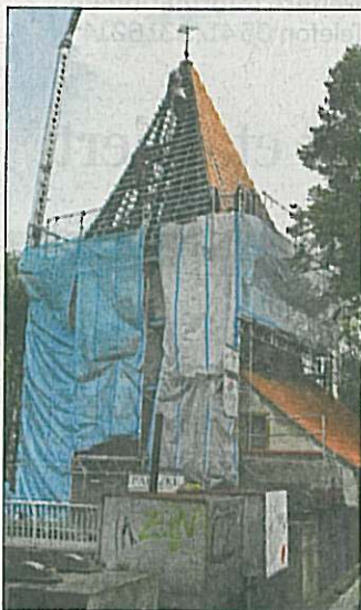
Die neuen Dachpfannen werden mit Sturmklammern befestigt, damit sie nicht herabfallen.
